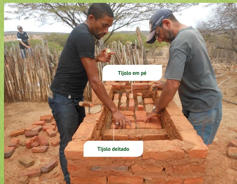
barro molhado, preenchendo todos os espaços entre os tijolos para acabamento. Em seguida, constrói uma parede ao lado, deixando apenas o tamanho da câmara de combustão, que será da largura das lajotas;
